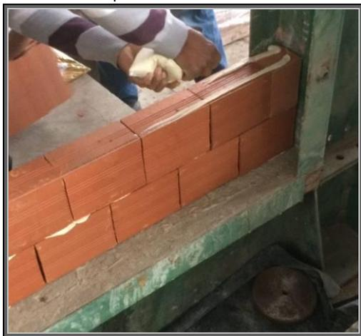
Figura 4 – Detalhe de conformação de cordão de argamassa para assentamento dos blocos
