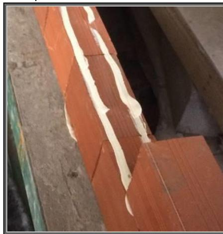
**Figura 5 – Vista geral do assentamento dos blocos cerâmicos e confecção da parede para ensaios**
